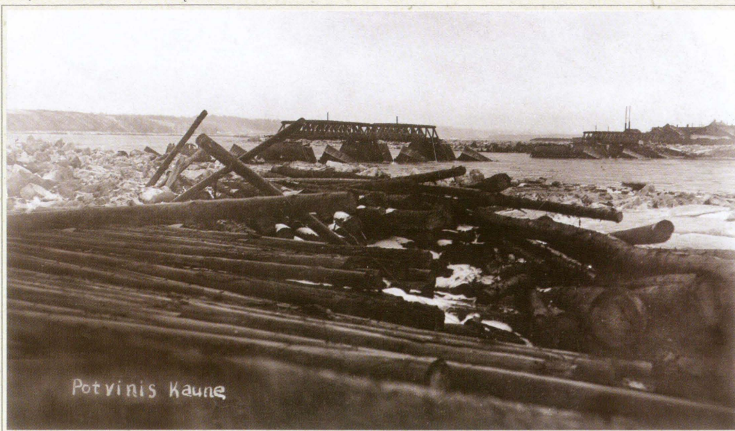
Eigulių tilto liekanos po 1926 m. potvynio prie nunešto Vilijampolės tilto liekanų.
