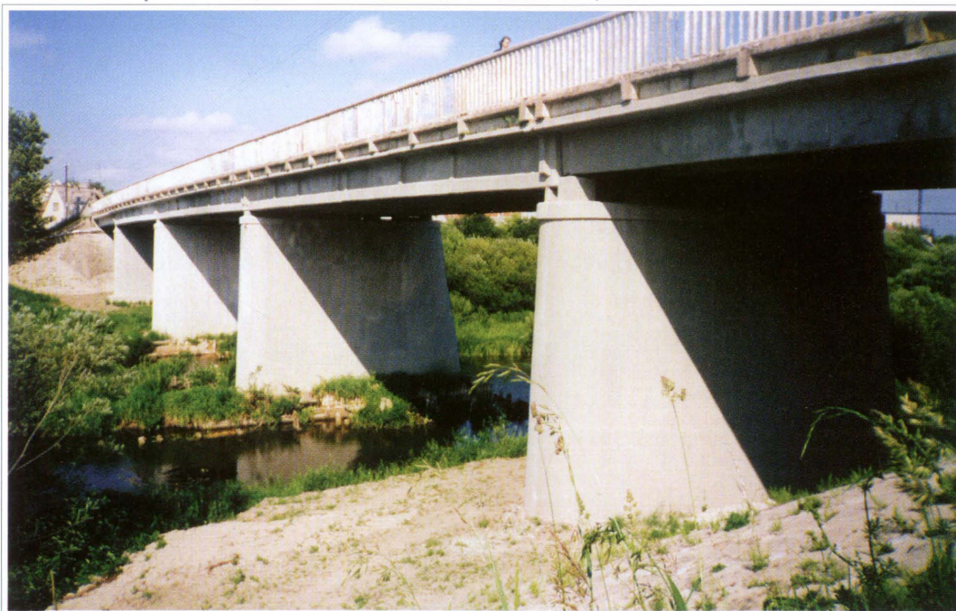
Tiltas pastatytas 1965 m. Tai penkių tarpatramių, gelžbetoninis, karpytos sistemos tiltas. Pirmas ir penktas tarpatramiai perdengti 16,76 m ilgio sijomis. Antras, trečias ir ketvirtas tarpatramiai perdengti 24,95 m ilgio sudurtinėmis sijomis su skersinėmis diafragmomis.
