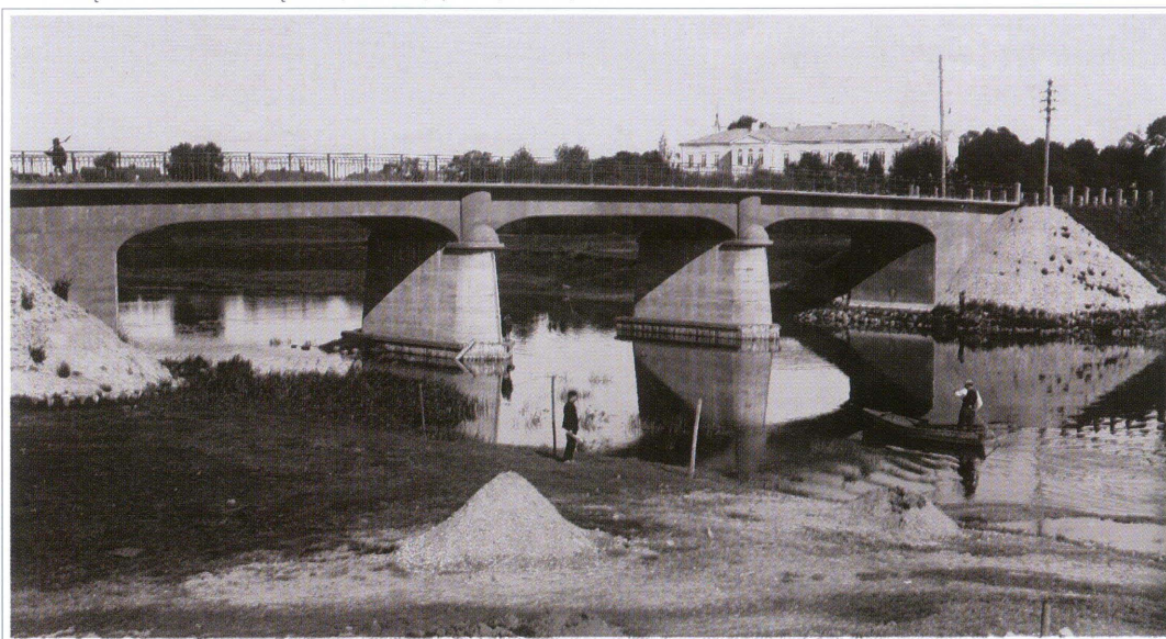
Tarpučių tiltas per Šešupę kelyje Marijampolė—Kybartai pastatytas 1926 metais. Projekto autorius inž. Pranas Markūnas. Bendras tilto su ramtais ilgis — 68 m.
