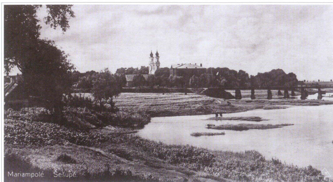
Tarpučių medinio tilto vaizdas iš šiaurės vakarų pusės, 1925 m.
